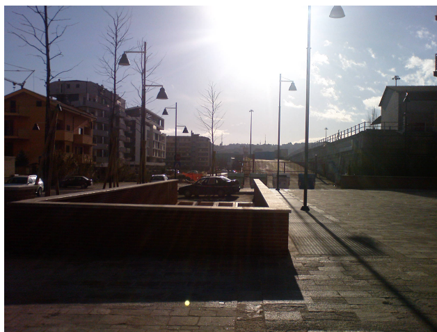
La rampa di uscita dai parcheggi che emerge dal marciapiede, si trova sull'allineamento del rilevato ferroviario che verrà costeggiato dalla linea filobus
